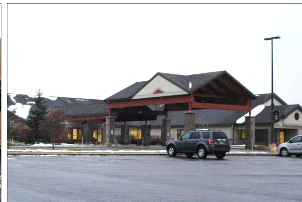
MANISTIQUE TRIBAL COMMUNITY CENTER IN MANSITIQUE, MICH.
